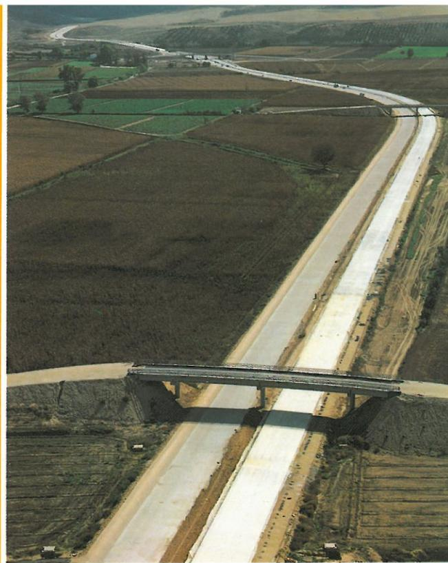
La sección geométrica está formada por dos calzadas de 7,50 m cada una, con sendos arcenes de 0,75 m el interior y 2,25 m el exterior. La separación entre bandas blancas interiores es de 6,50 m.
