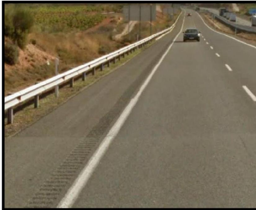
*Fotografía 7: A-3 (Valencia) – GSLF de borde de calzada adyacente a marca vial.*
