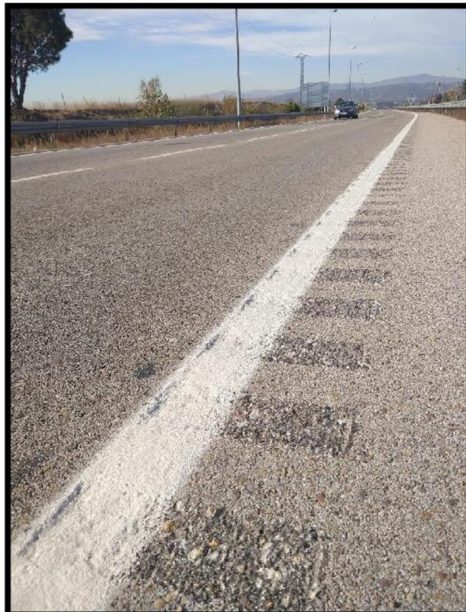
*Fotografía 4: M-505 (Madrid) - GSLF de borde adyacente a marca vial tipo paralelogramo.*
