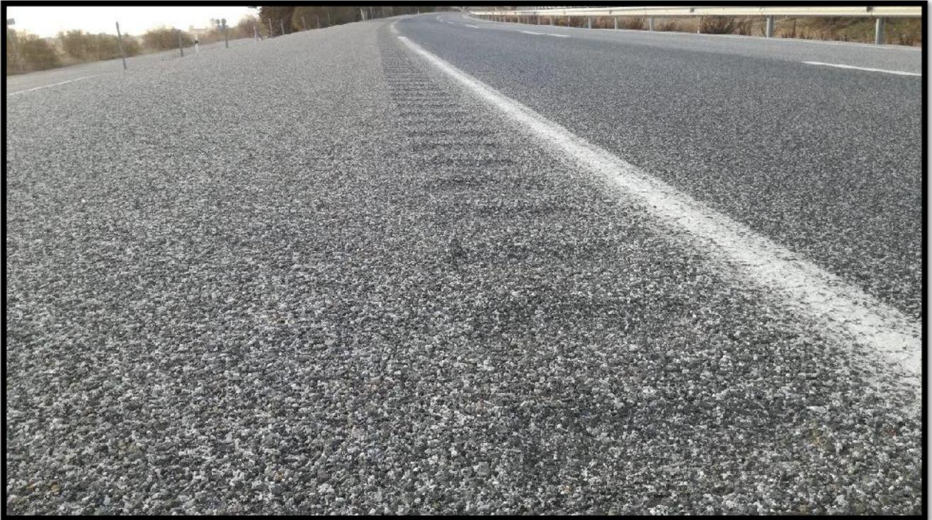
*Fotografía 1: A-92 (Granada) – GSLF de borde de calzada adyacente a marca vial tipo paralelogramo.*
