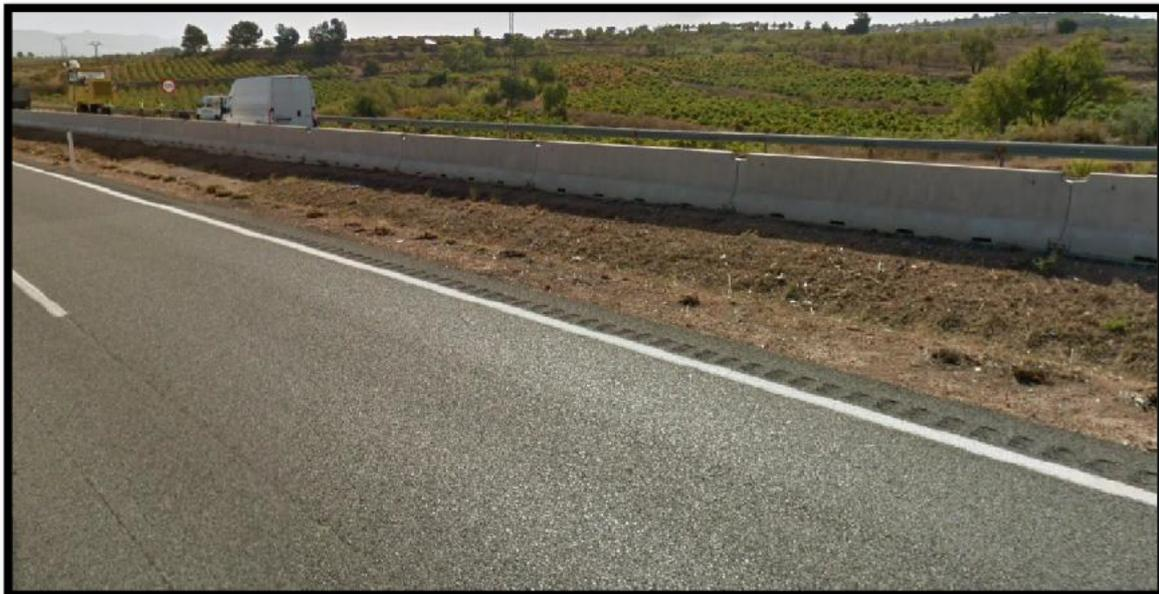
*Fotografía 8: A-3 (Valencia) – GSLF de borde de calzada adyacente a marca vial*
