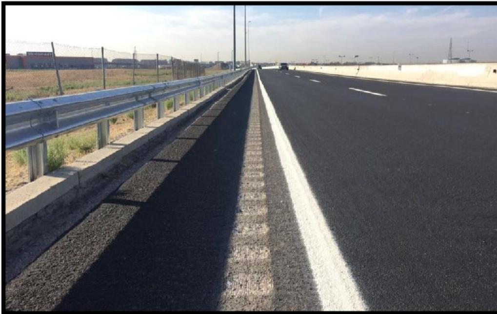
*Fotografía 3: M-506 (Madrid) - GSLF de borde adyacente a marca vial tipo paralelogramo.*
