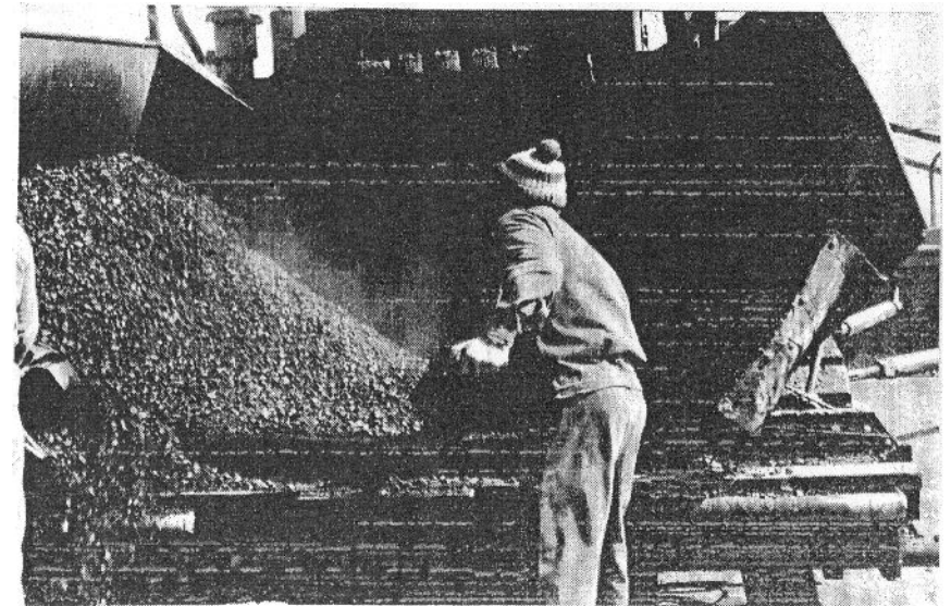
Fig. 4.37 TOLVA DE RECEPCION
