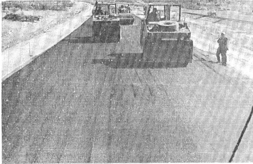
Fig. 8.9 MARCAS DEJADAS POR LA COMPACTACION PRINCIPAL. AL FONDO, RODILLOS ELIMINANDO ESTAS MARCAS
