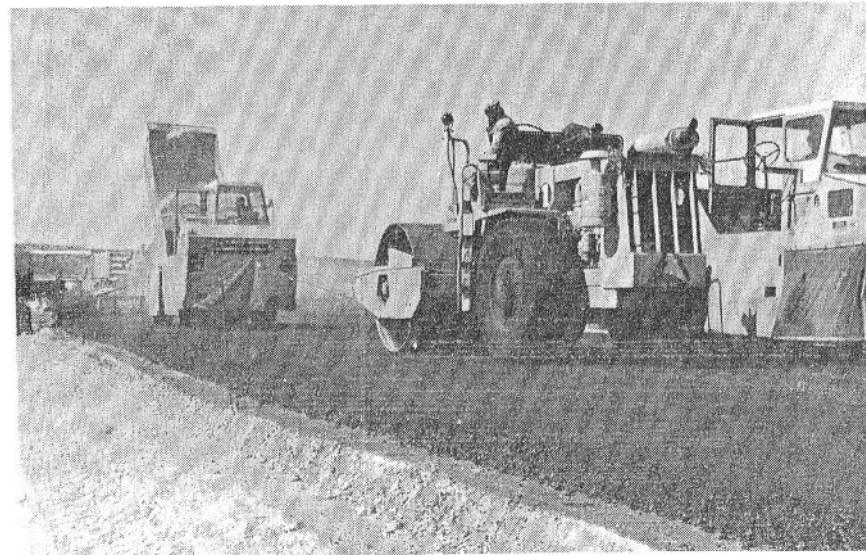
Fig. 4.46 APISONADORA MIXTA NEUMATICOS-VIBRANTE
