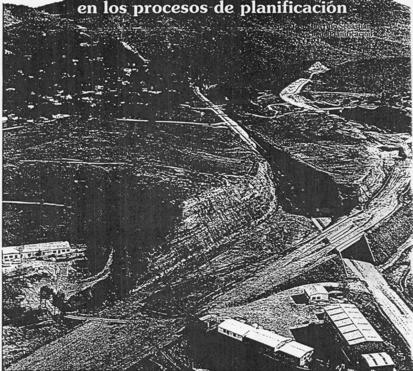
El impacto medio-ambiental de las vías de gran capacidad (autopistas y autovías) puede ser muy elevado si no se adoptan las medidas preventivas y correctoras adecuadas. En las fotos adjuntas se pueden observar los grandes movimientos de tierra en la autopista Tarrasa-Manresa y en la autovía Santander-Torrelavega.
