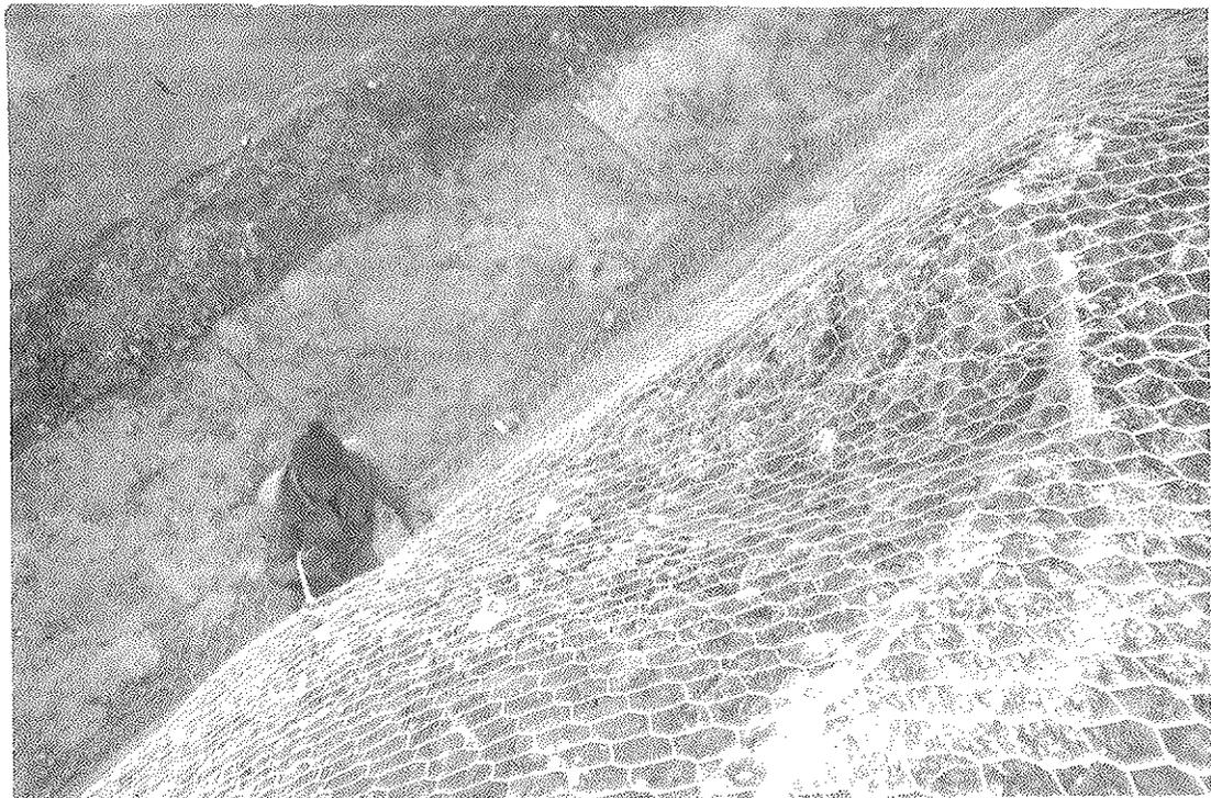
Figura 2.20. — Mallas de protección contra desprendimientos (cortesía de A. Bianchini, Ingeniero, S. A.).
