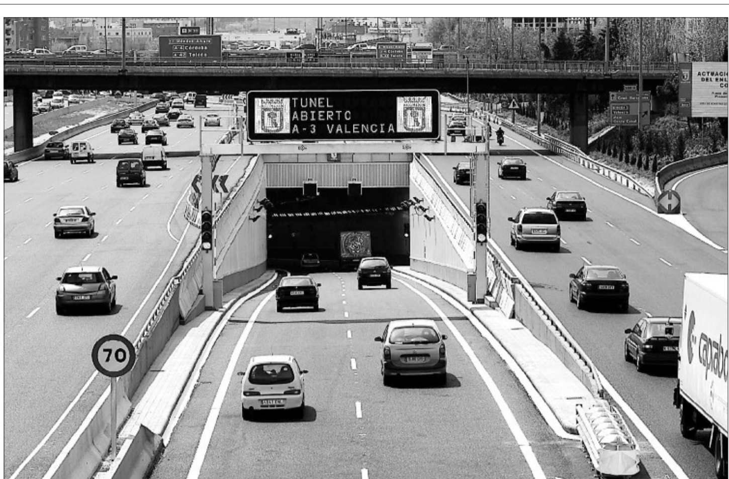
Entrada al túnel que desde ayer conecta la M-30 norte con la autovía de Valencia. / ULY MARTÍN
